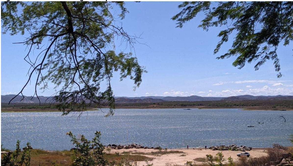
Figura 17. Geossítio Barragem Boqueirão.
